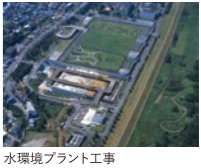
水環境プラント工事
