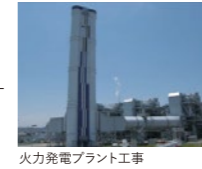
火力発電プラント工事
